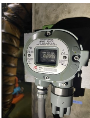
ภาพที่ 2.2-42 การติดตั้ง Gas Detector
