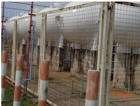
ภาพที่ 2.2-39 รั้วตาข่ายโปร่งกัน และเสาป้องกันการกระแทก บริเวณลานถังเก็บ LPG
